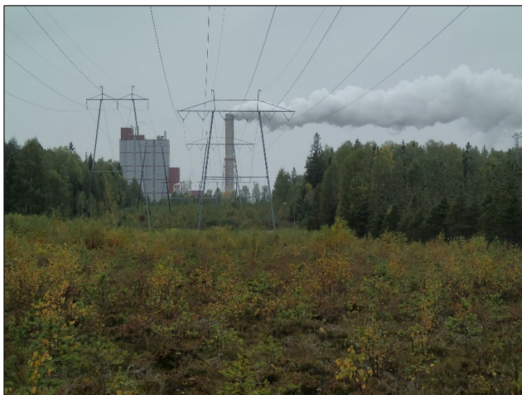
Kuivattua suomaastoa linjakäytävällä Uimaharjun tehtaiden koillispuolella.
