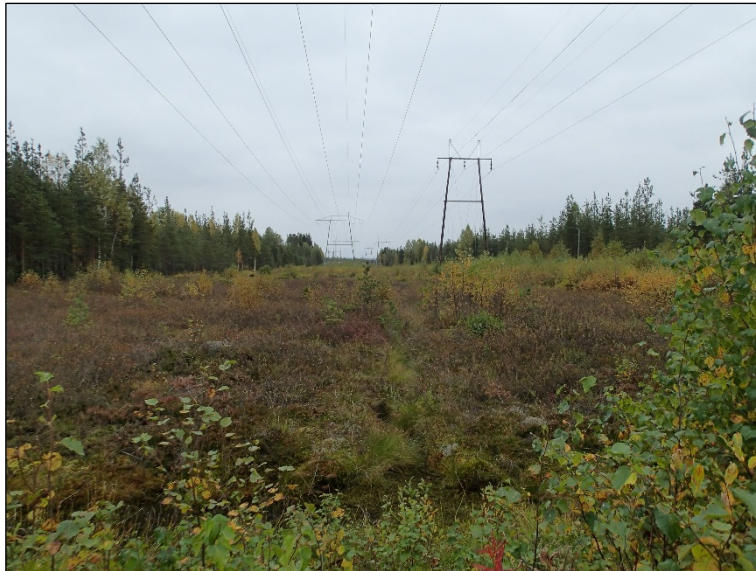
Kuivattua suomaastoa linjakäytävällä Uimaharjun tehtaiden koillispuolella.
