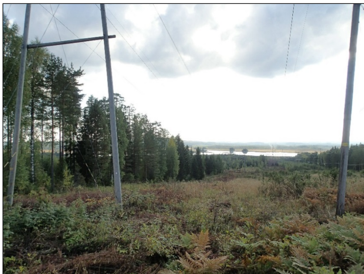
Inventointimaastoa linjakäytävällä Pamilon voimalan lounaispuolella. Taustalla Jäsyes. Pusikkoista ja kosteapohjaista maastoa Palojoen rannassa.
